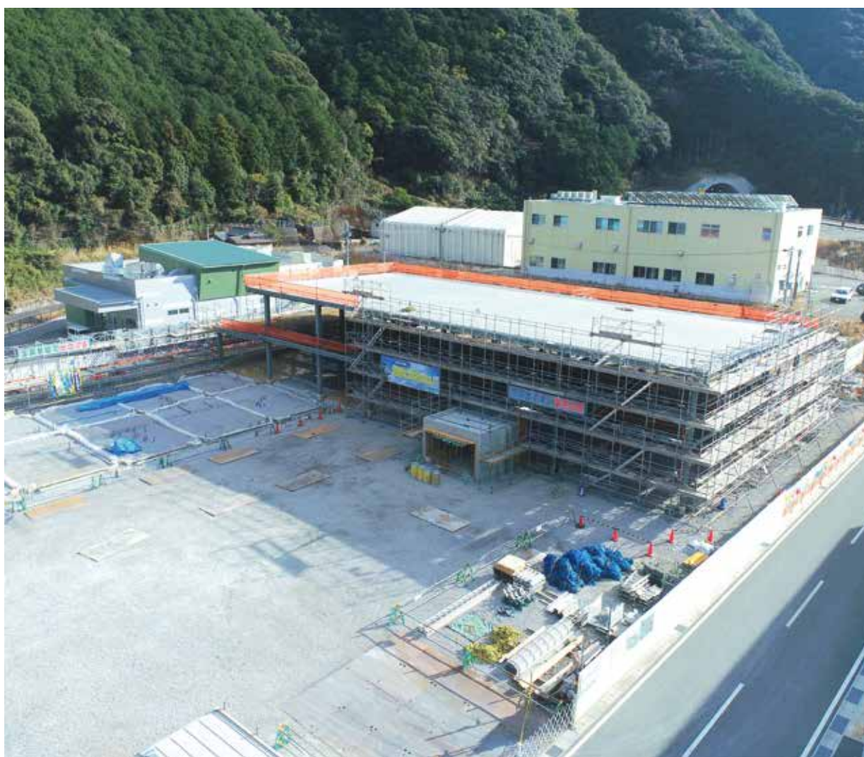
建設中新すさみ病院（令和5年1月5日撮影）
