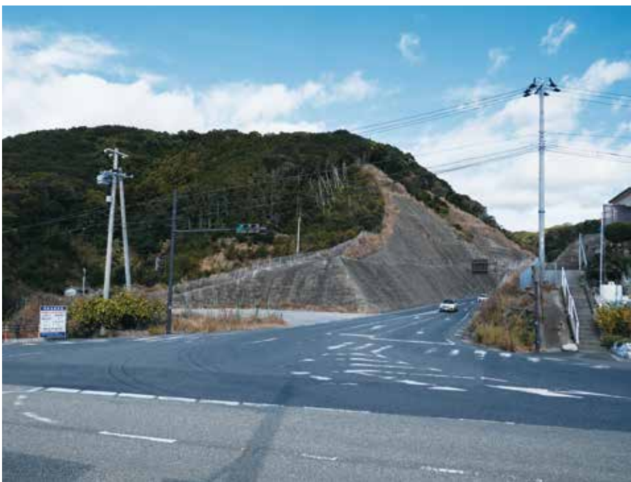
江住避難所建設予定地周辺
