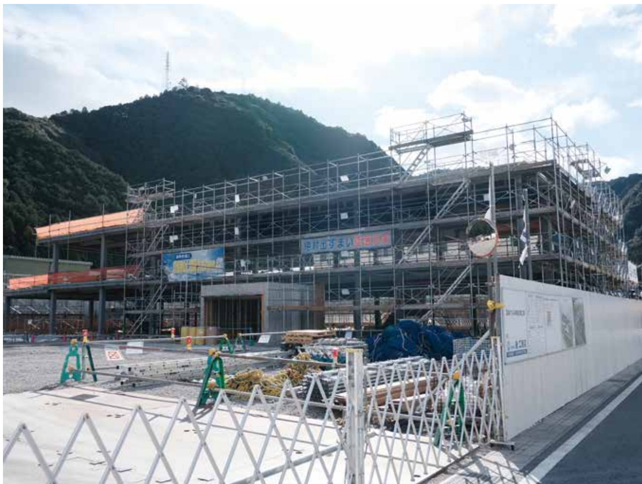
(建設中の新すさみ病院)
