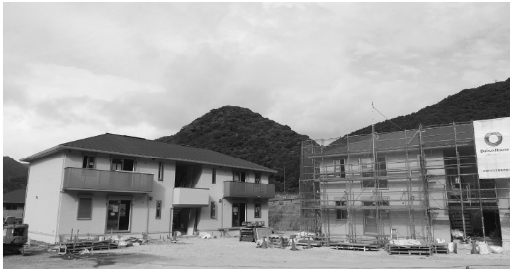
建設中の子育て世帯向け住宅
