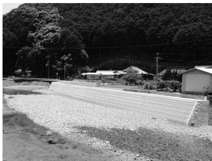
(太間地護岸工事)
