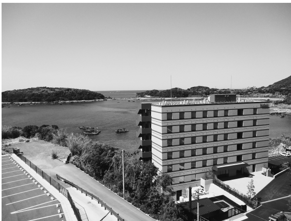
(完成したマリオットホテル)
